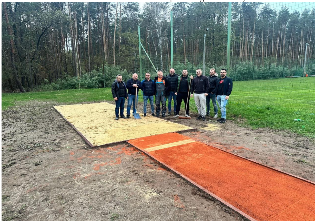
Zdjęcie 15. Budowa skoczni w dal przy SP Przyłek przez mieszkańców Przyłęka
