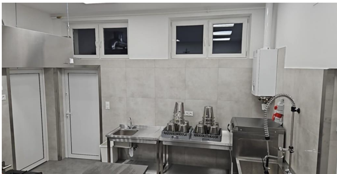
Rys. 15.16 Zmodernizowane wnętrza budynku remizy OSP w Przylęku (zaplecze kuchenne)
