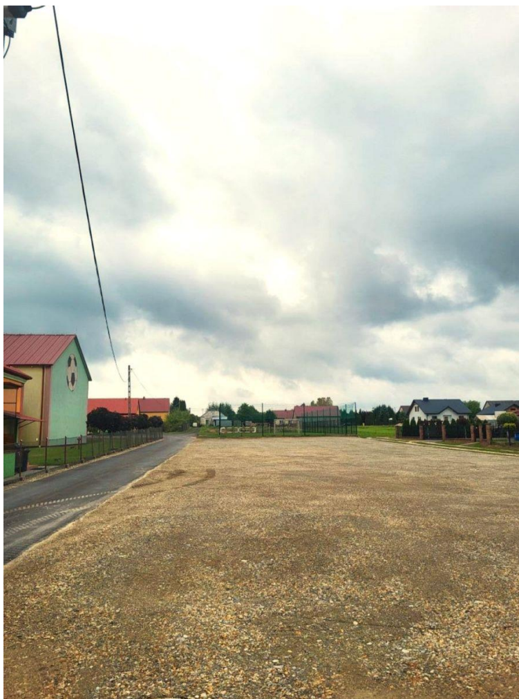
Rys.20, 21 Utwardzenie terenu pod parking i drogi dojazdowej do żłobka w Siedlance
