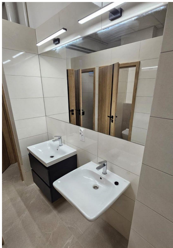
Rys. 13, 14 Modernizacja wewnętrzna w budynku remizy OSP w Zapolu
