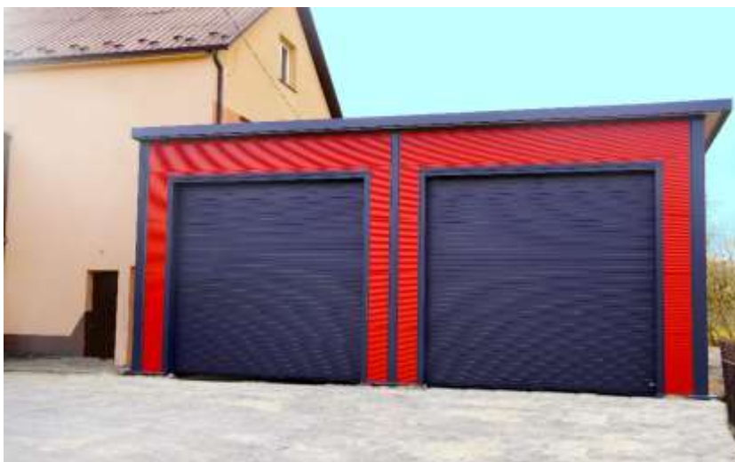
Rys. 33 Garaż dla samochodów pożarniczych przy remizie OSP Siedlanka
