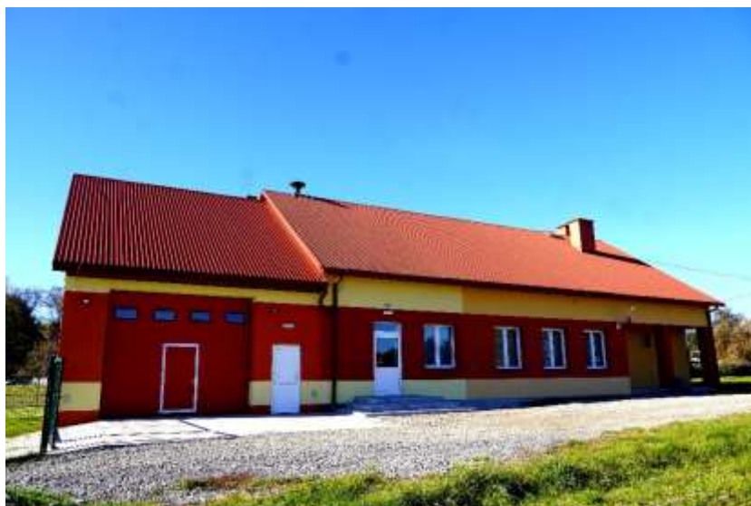
Rys.30 Remiza OSP w Zapolu po remoncie 2023r.
