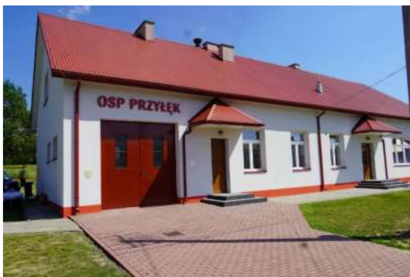
Rys. 29 Zmodernizowana remiza OSP w Przyłęku – 2023r.
