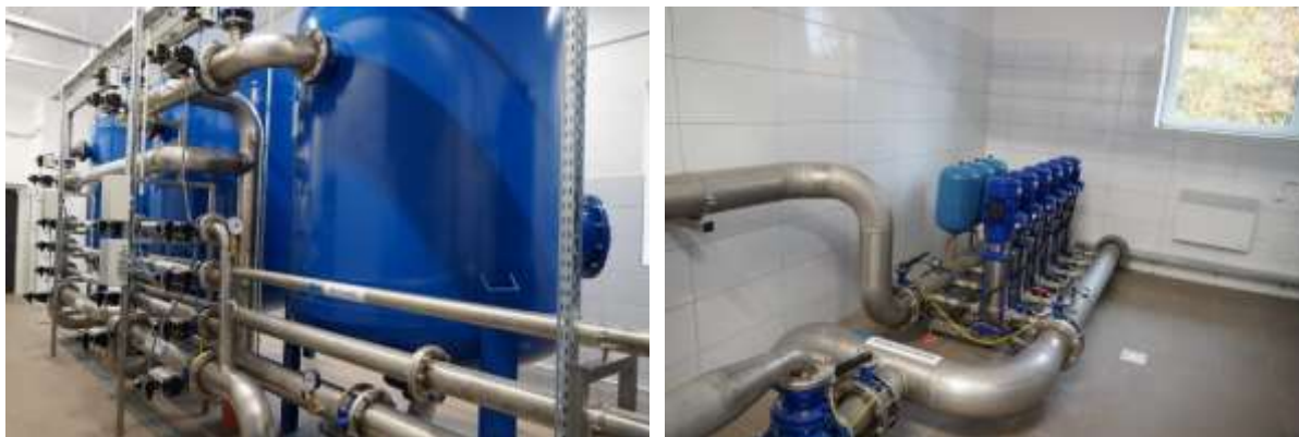
Rys. 2, 3 Przebudowana hydrofornia wody w Niwiskach
