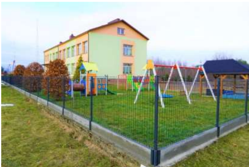
Rys. 12, 13, 14 wymiana pokrycia dachowego, ogrodzenie i remont boiska przyszkolnego w Szkole Podstawowej w Hucisku
