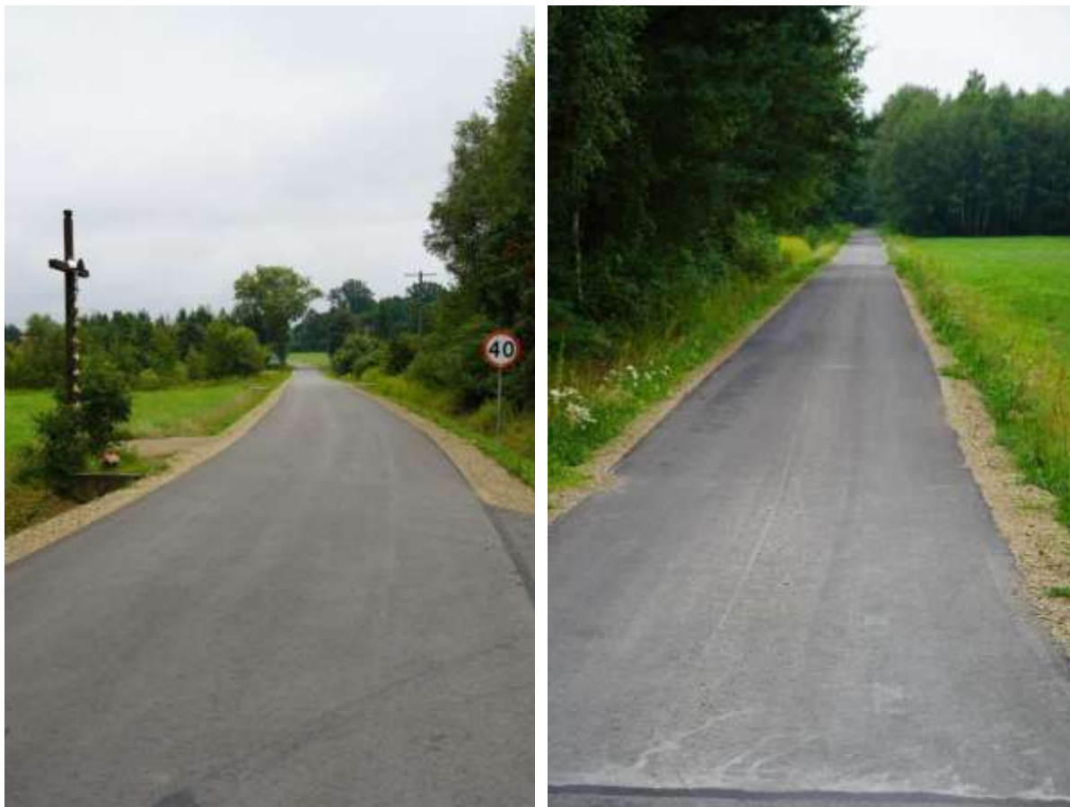
Rys. 7, 8 Przebudowane drogi gminne w 2023r.
